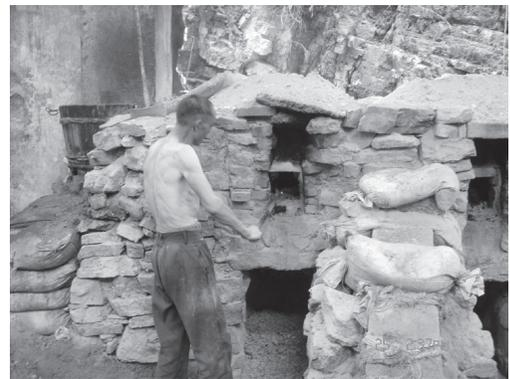
図3 水銀の精錬作業(カマドで鉱石を焼き、水銀蒸気にした後、冷却すると金属水銀ができる)
