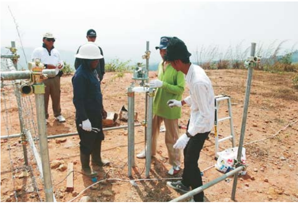
写真3 現地設置風景
