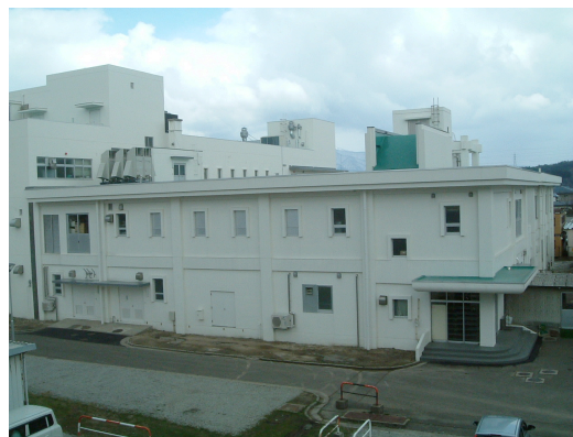
増改修後の動物実験棟（3,500 m 2 ）
